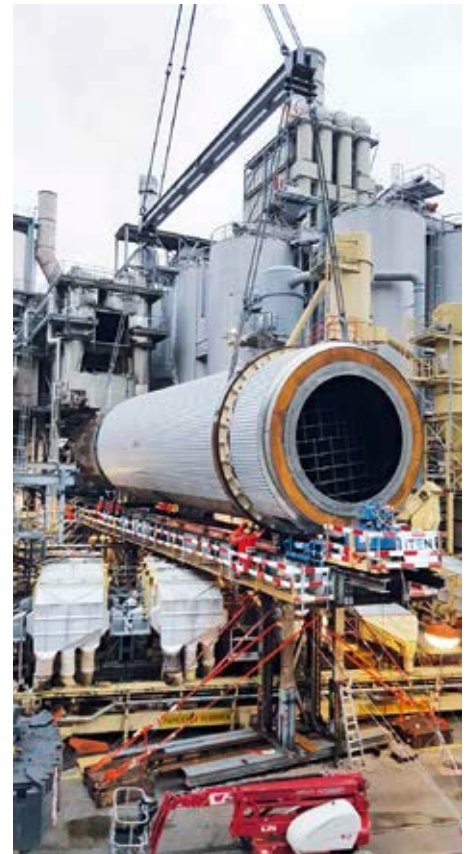
Es folgt die neue Trommel auf dem Montage-schlitten
