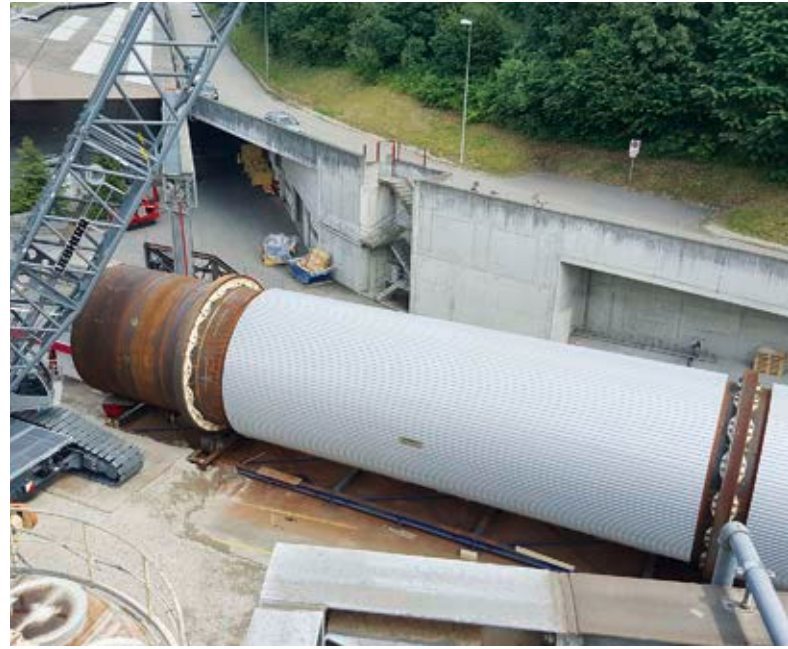
Die neue Trommel, zur Montage bereit
