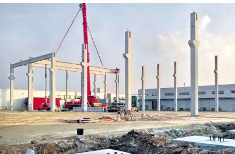
Montage der Träger
