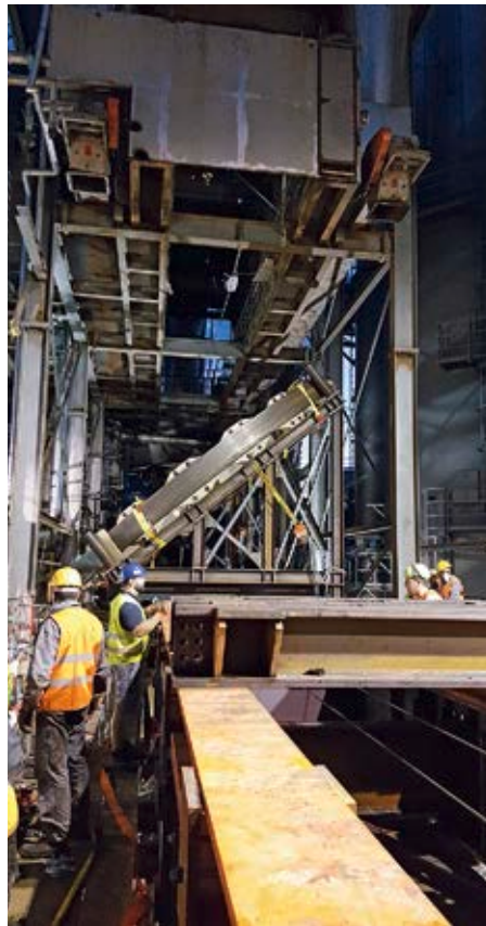
Der hintere Laufring muss zuerst durch den engen Stahlbau
