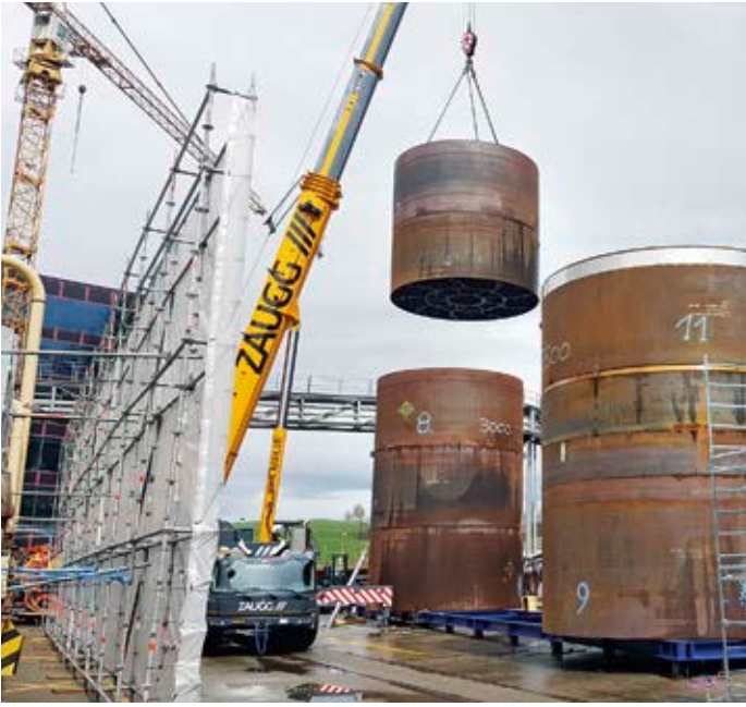
Zusammenbau der neuen Büttner-Trommel im Werk direkt neben der Einbaustelle
