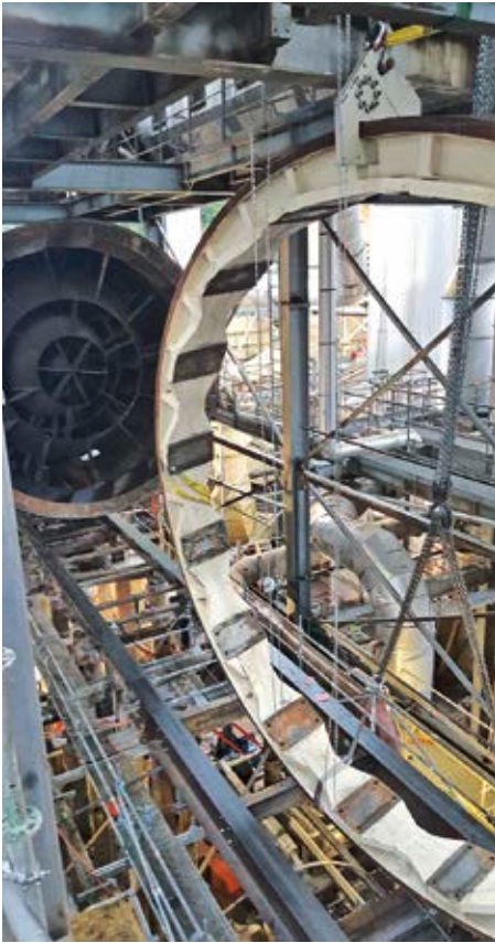
Nach dem Einschieben wird der hintere Lauftring aufgezogen
