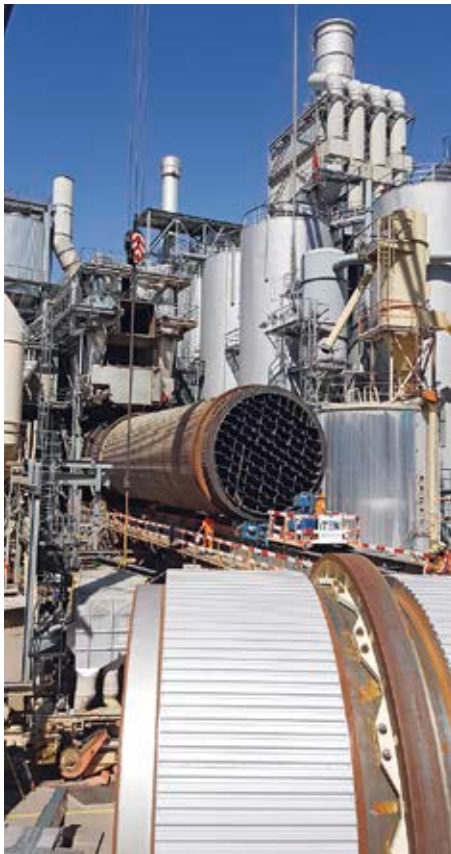
Die alte Trommel wird herausgefahren, während die neue Trommel schon bereitliegt
