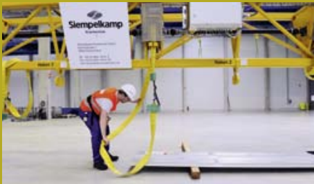
Stabile Gurte werden um die Langteile gelegt
