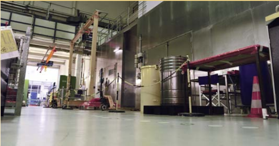
Der Dekontbox-Bereich im Kernkraftwerk Krümmel
