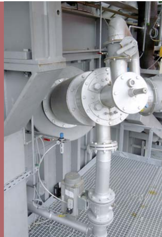
Staubbrenner 2,4 MW
