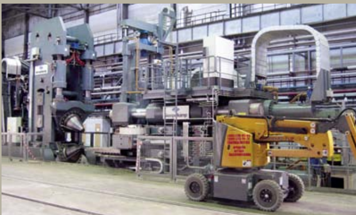
Ringwalze bei Electrostal im Rohbau
