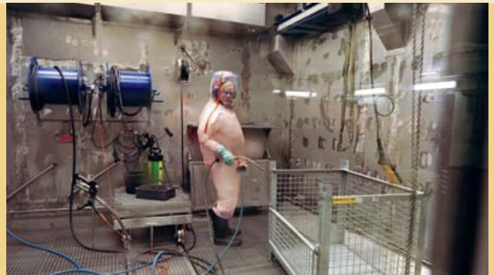
In der Nassbox der Siempelkamp-Dekontbox werden gerade Bauteile gereinigt
