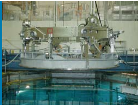
RDB-Dichtdeckel vor dem Eintauchen in die geflutete Reaktorgrube
