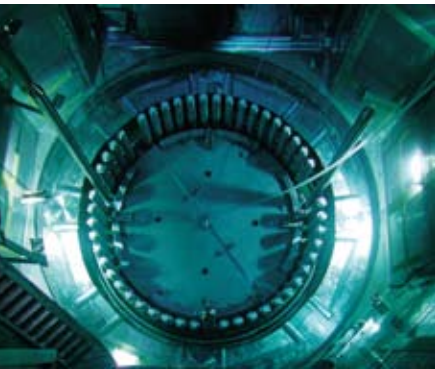
Der Dichtdeckel verschließt den offenen Reaktor bei gefluteter Reaktorgube
