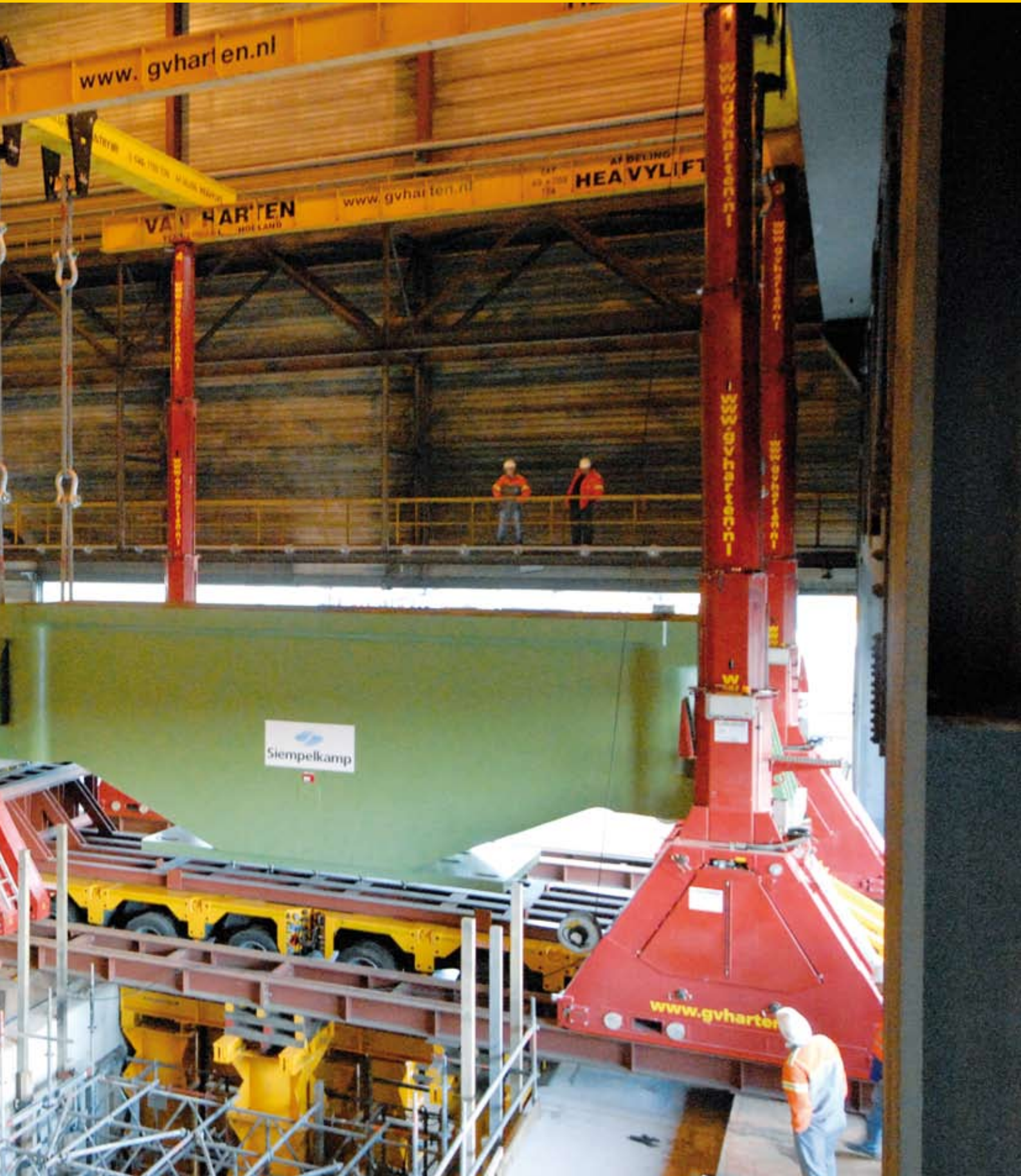
Unterholm für die Presse auf der Baustelle
