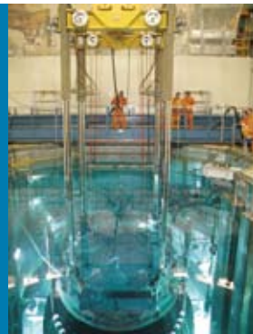
Transport des Dichtdeckels mit der SNT-Kombihebetraverse im Containment
