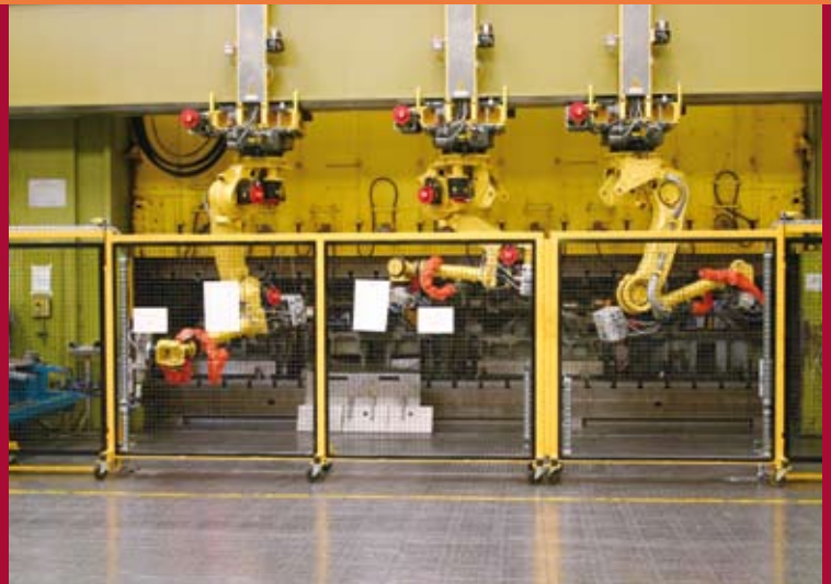
Die schwebende Rahmenlagerung mit drei Robotern an jeder Seite der Längsträgerpresse
